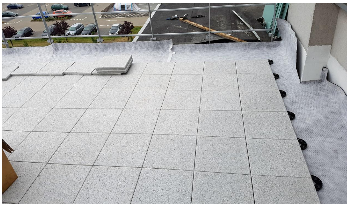
5. Rozstawiamy wsporniki i układamy płyty.
